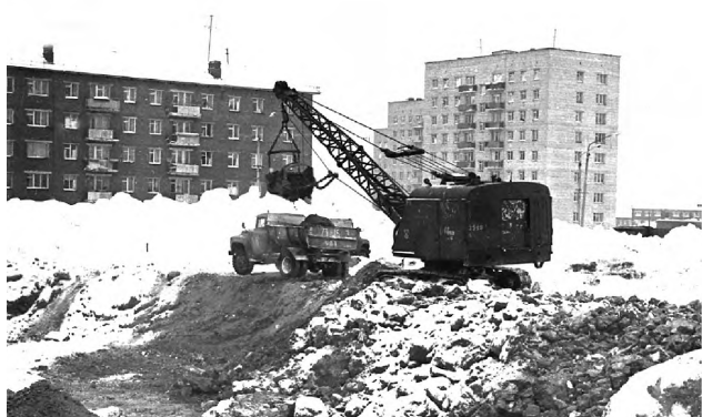
Начальные работы по закладке фундамента здания Дворца культуры «Электрон», 1976 год
